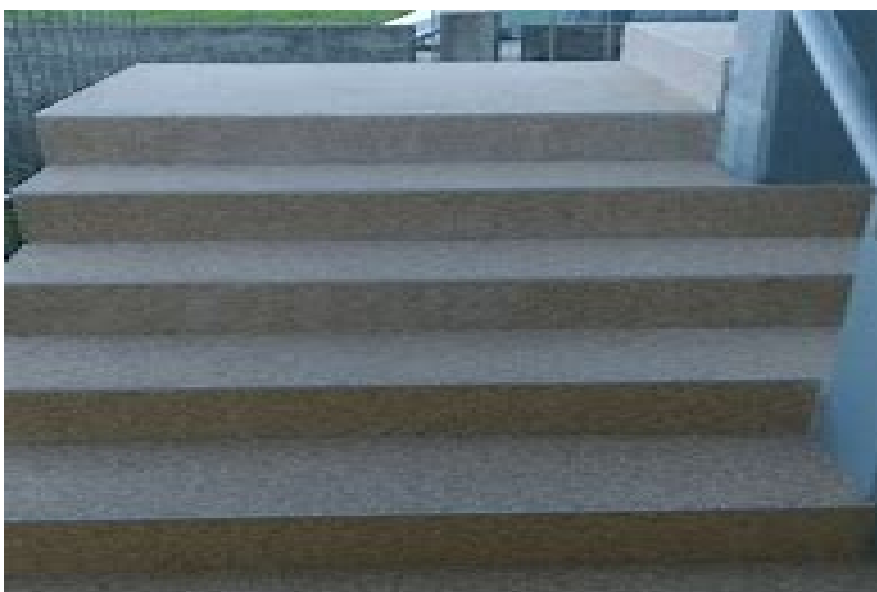
Scala rivestita con pavimento in resina e graniglia.
