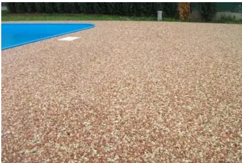
Rivestimento in graniglia e resina per bordo piscina.
