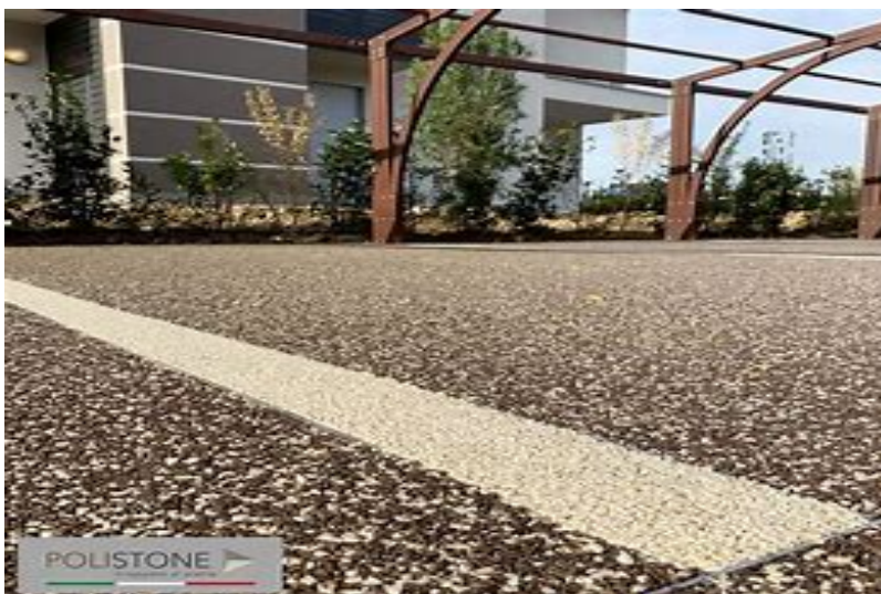
Pavimentazione drenante in resina e graniglia per esterni.
