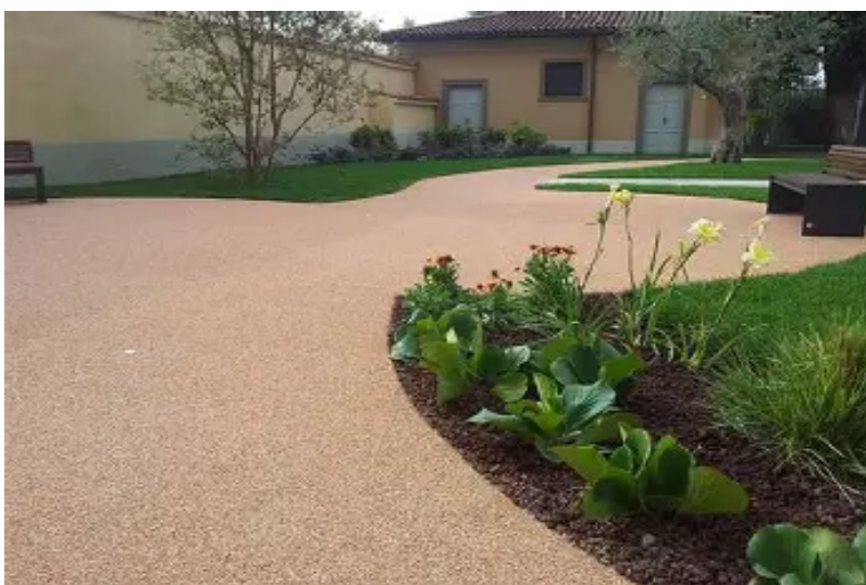
Percorso pedonale con pavimentazione in resina e graniglia.
